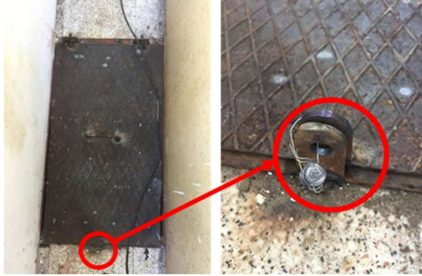
Şekil 6 Platform Altına Erişimi Engellemek İçin Örnek Damgalama
