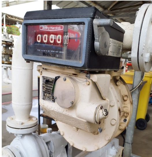
Şekil 1 Su Dışındaki Sıvılar İçin Ölçme Sistemi
