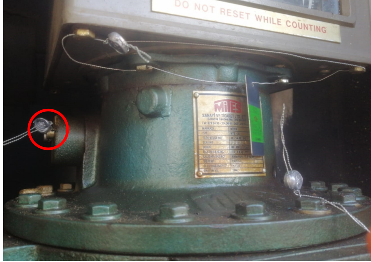
Şekil 3 Brodimetre Ayar Mekanizması Damgalaması
