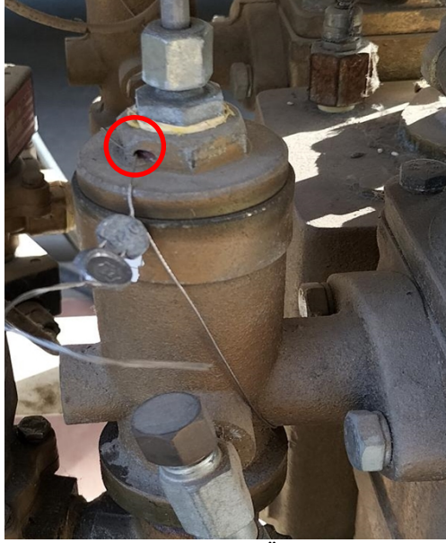
Şekil 7 Diferansiyel Valf Örnek Damgalaması
