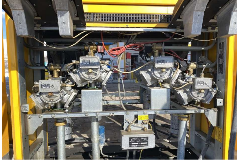
Şekil 2 Brodimetre Pulser Grubu Genel Görünüş
