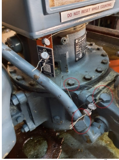
Şekil 4 Metre Kapak ve Metre Hava Ayırıcısı Örnek Damgalaması
