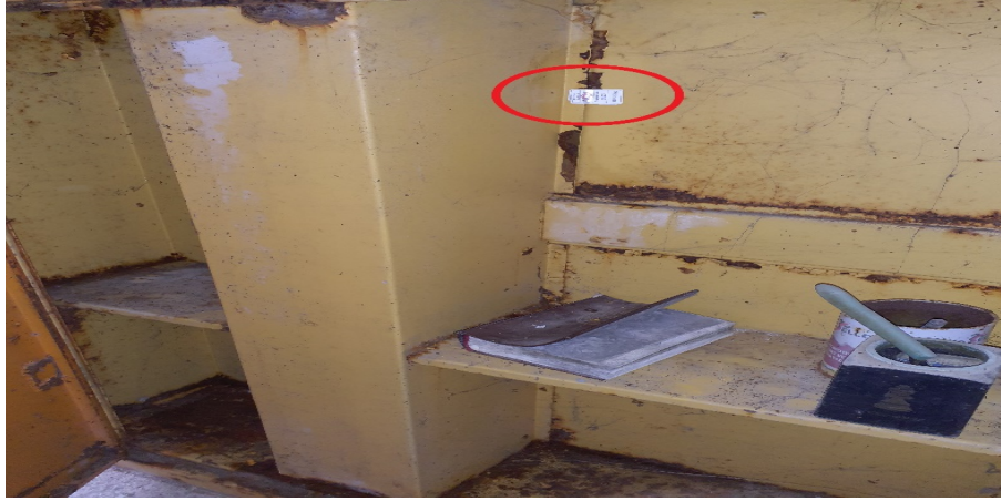
Şekil 5 Çeki Çubuğu Muhafazası Damgalaması
