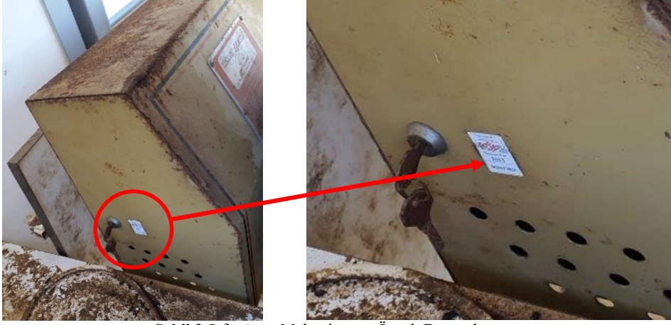
Şekil 2 Sıfır Ayar Mekanizması Örnek Damgalaması
