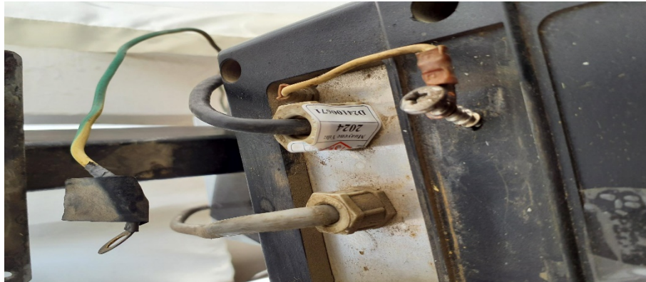
Şekil 4 Yük Hücresi Gösterge Bağlantısının Damgalaması
