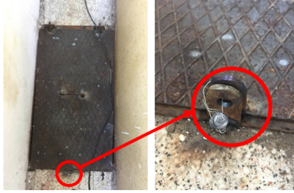
Şekil 6 Platform Altına Erişimi Engellemek İçin Örnek Damgalama
