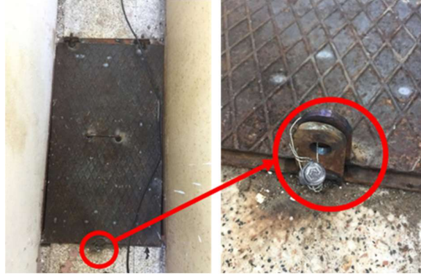
Şekil 6 Platform Altına Erişimi Engellemek İçin Örnek Damgalama
