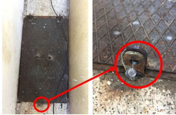
Şekil 6 Platform Altına Erişimi Engellemek İçin Örnek Damgalama
