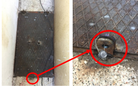
Şekil 7 Platform Altına Erişimi Engellemek İçin Örnek Damgalama
