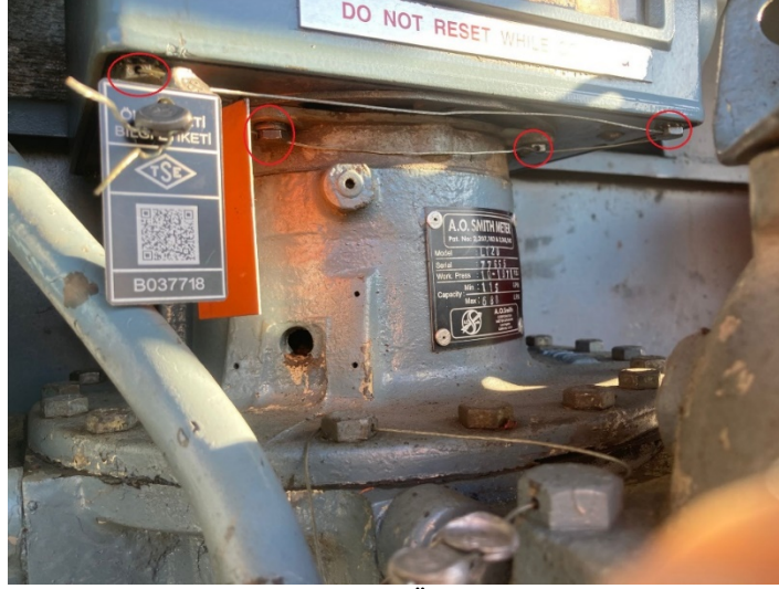
Şekil 2 Mekanik Gösterge Örnek Damgalaması
