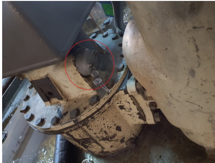
Şekil 3 Brodimetre Ayar Mekanizması Damgalaması
