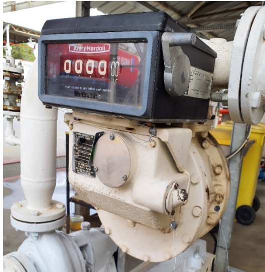
Şekil 1 Su Dışındaki Sıvılar İçin Ölçme Sistemi
