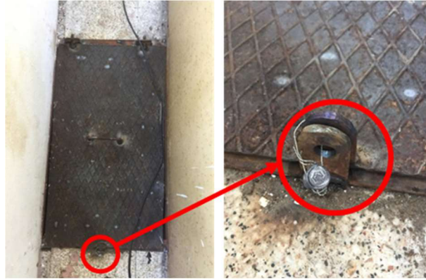
Şekil 8 Platform Altına Erişimi Engellemek İçin Örnek Damgalama
