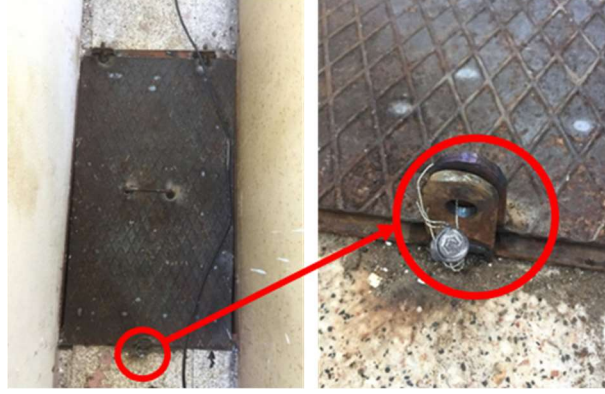
Şekil 7 Platform Altına Erişimi Engellemek İçin Örnek Damgalama
